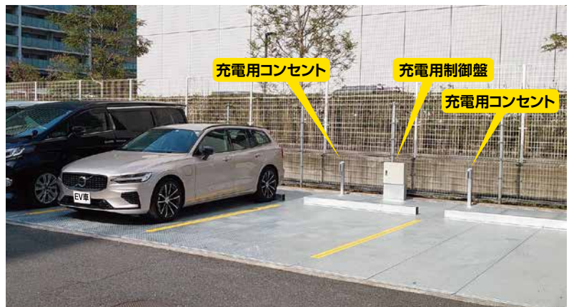
立駐機を解体して鋼材で塞ぎ、充電専用駐車場とした。
