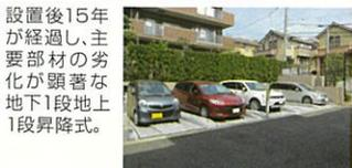
設置後15年が経過し、主要部材の劣化が顕著な地下1段地上1段昇降式。
