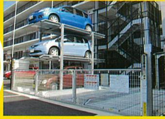
地下2段地上1段昇降式ビット収納型ゲート
