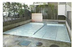
上面の平板は滑り止め効果の高い編鋼板を使用していますので雨天時も安全です
